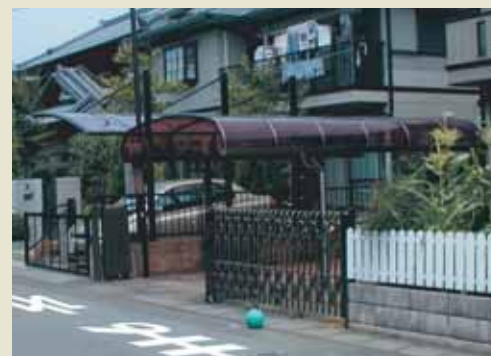
(屋根を設けた駐車場)
